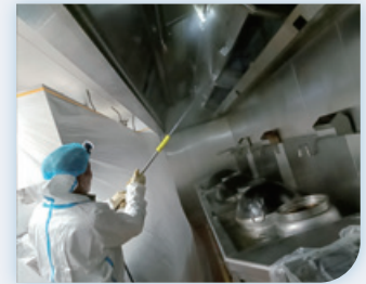
商管公司排煙管道改造
