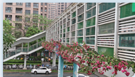
「空中花廊」煥新城市天橋
