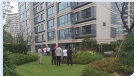
深安上居項目海綿城市技術應用
