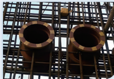
▲ 三段式止水套管的「柔性防水套管」安裝現場
