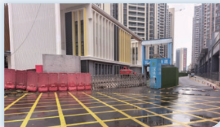
■ 施工路段地面沖洗
