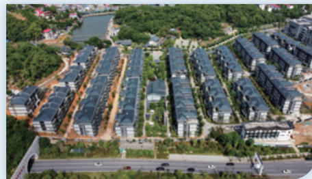
鵬南公司光伏泛光照明項目
