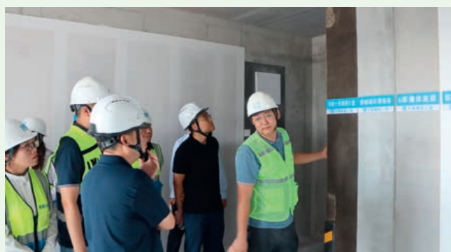
▲ 品控小组把控施工
