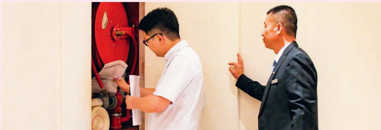
▲ 商管公司消防安全整治
