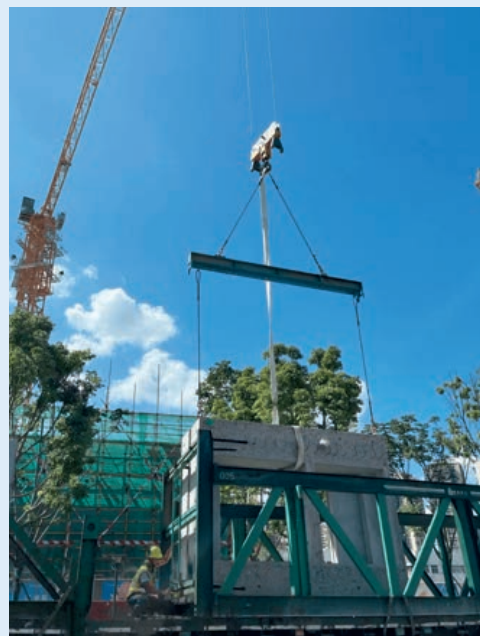
▲ 装配式施工现场图
