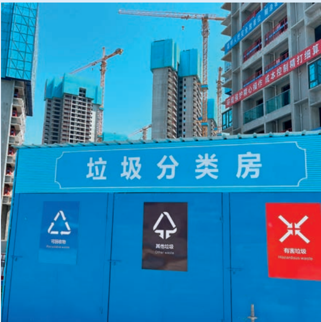
▲ 施工现场分类垃圾房
