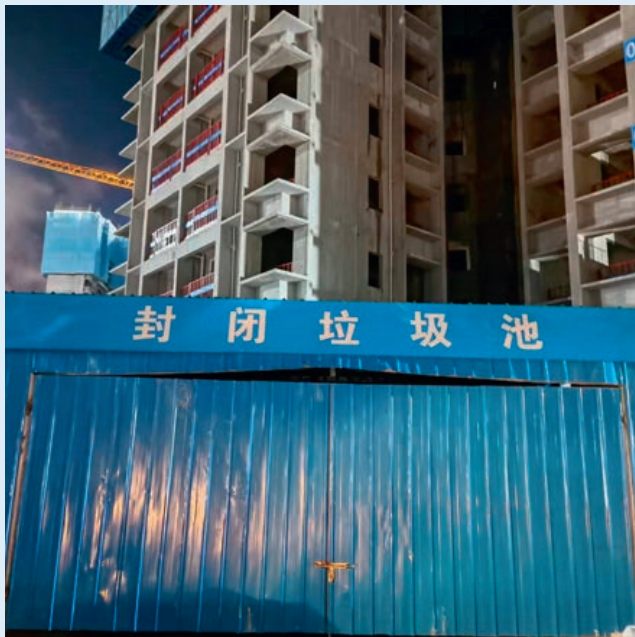
▲ 施工现场封闭垃圾池
