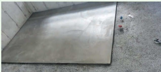
▲ 楼地面隔音涂料工艺
